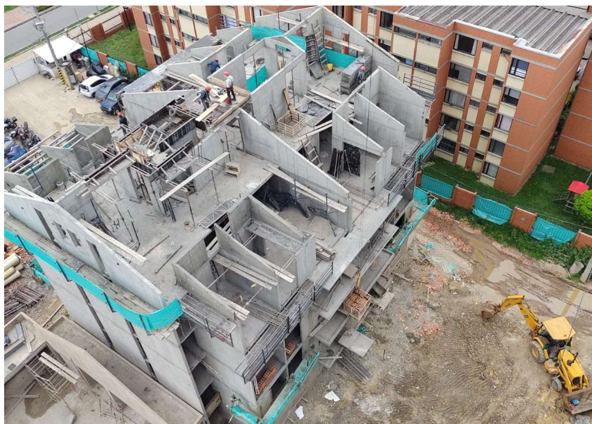
Imagen 3. Torre en proceso constructivo.
