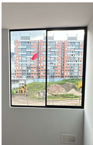
Imagen 17. Mantenimiento del selle de ventanería.
