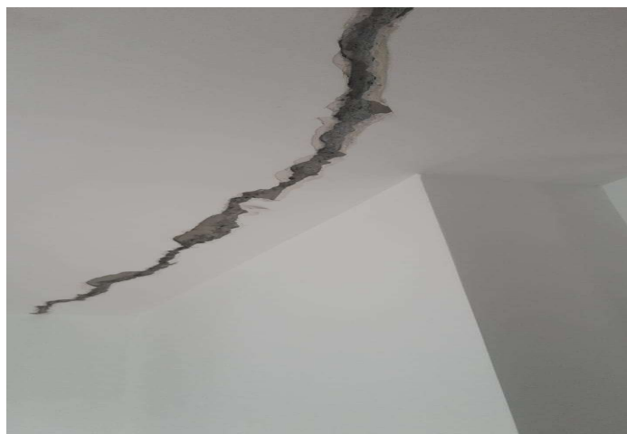
Imagen 6. Perforación o demolición parcial en placa techo.
