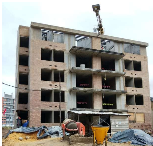
Imagen 5. Torre 1 en proceso constructivo.
