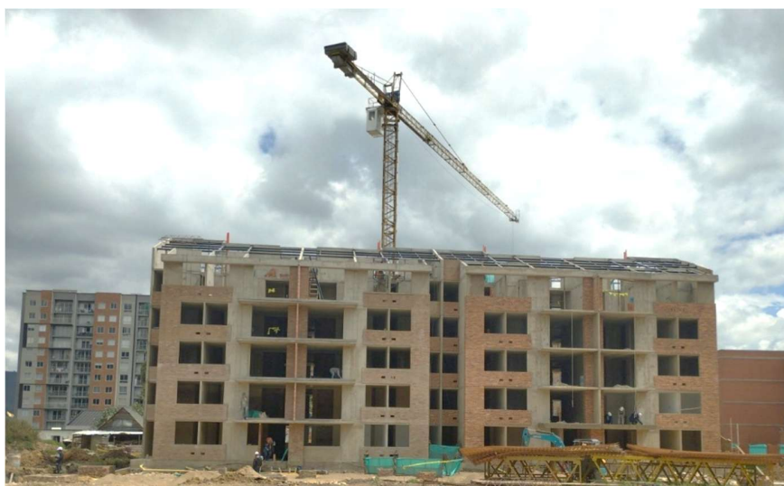
Imagen 4. Torre 2 y 3 en proceso constructivo.
