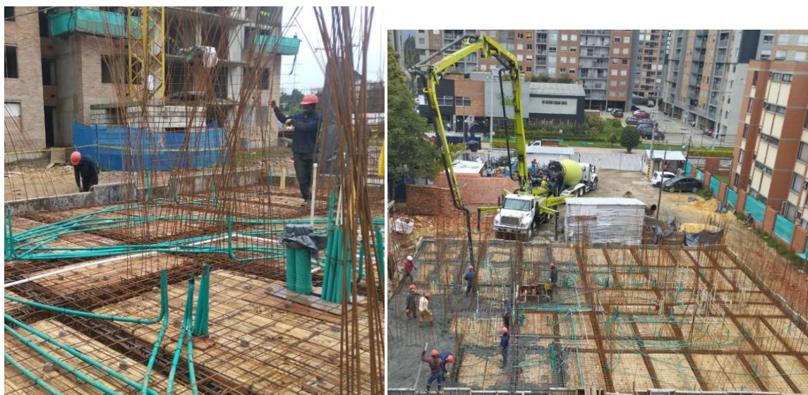
Imagen 2. Placa con instalaciones hidrosanitaria y eléctricas.
